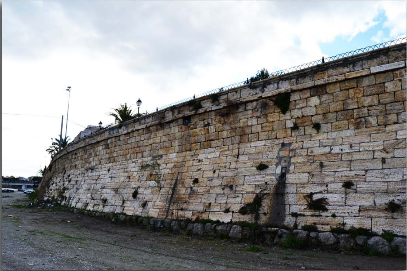
● Malecón de defensa de Albox. Construido en 1892 con sillares procedentes de las canteras de Los Marcelinos
