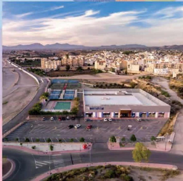
Centro Municipal "Agua y Salud" nuevas instalaciones
