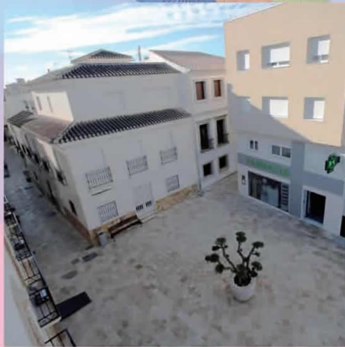
Nuevo enlosado calle Silvela y anexas
