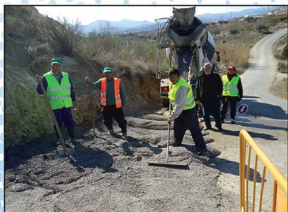
Asfaltos y arreglos de caminos rurales
