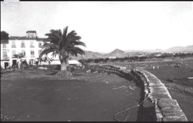
El Paseo del muro de 1892, tras las inundaciones de 1973
