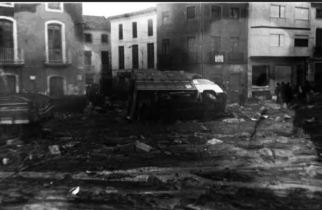
Estado de la Plaza Mayor tras las inundaciones de 1973
