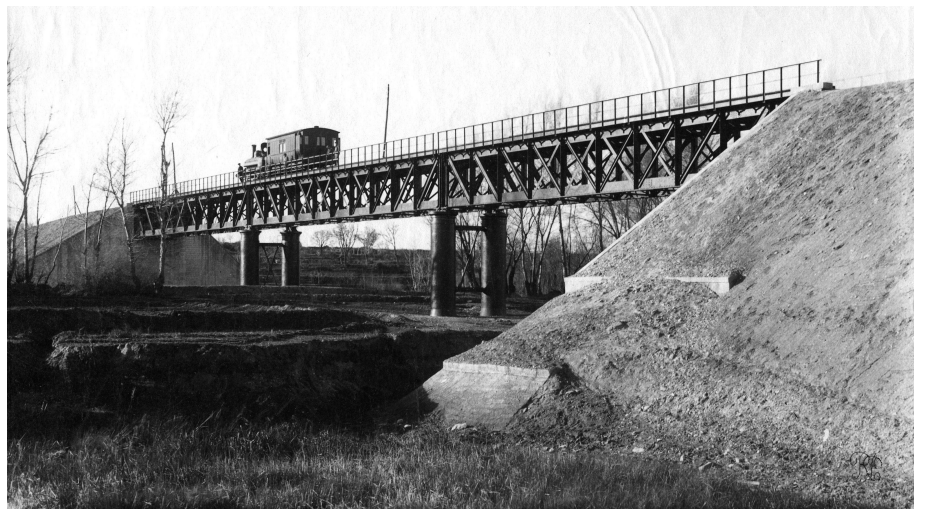
Puente del ferrocarril a su paso por Arboleas
