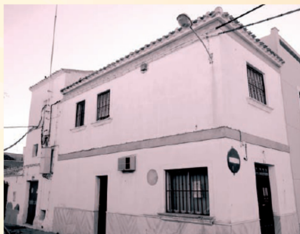
Estación de Sevillana en la calle Brigida Pardo
